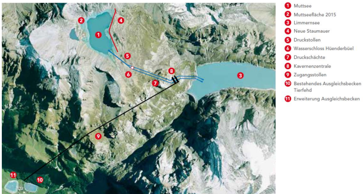
Abbildung 4: Kraftwerke Linth-Limmern. Quelle: Axpo.
