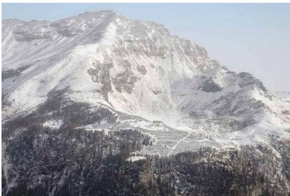
Figure 3: L'installation photovoltaïque alpine «Gundosolar» 13 sur les hauteurs de la commune de Gondo dans le Valais
