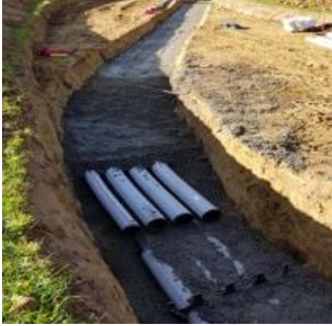
Figure 4: Blocs de tubes superposés
