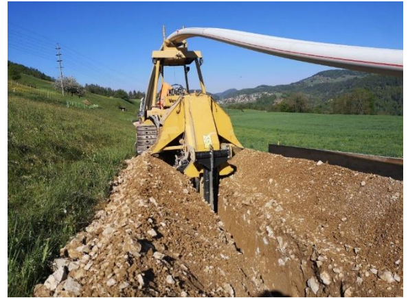
Figure 37: Exemple de pose par trancheuse à roue 2
