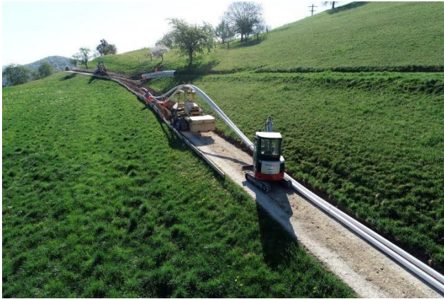
Figure 36: Exemple de pose par trancheuse à roue 1
