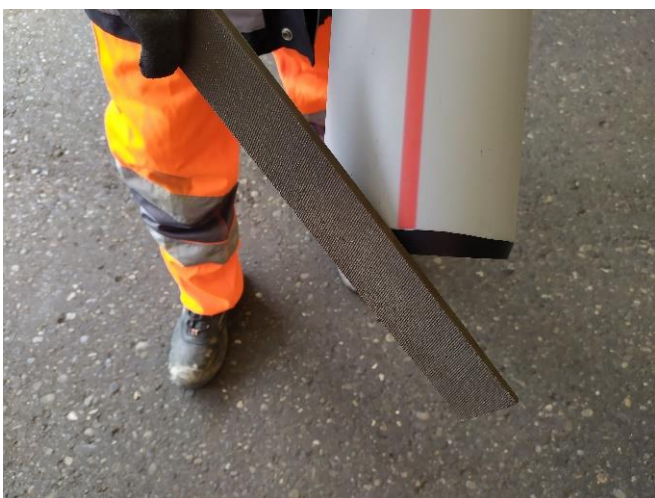
Figure 14: Chanfreinage avec râpe
