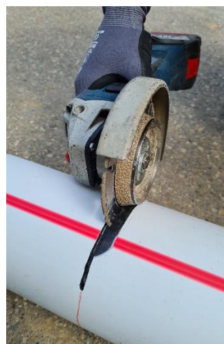
Figure 15: Coupe avec disque à chanfreiner
