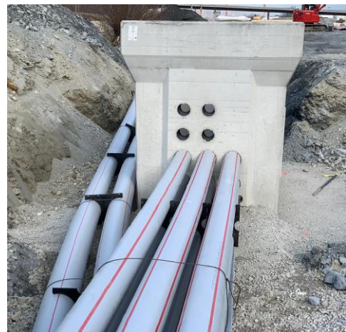
Figure 25: Regard en béton sur mesure fabriqué sur place
