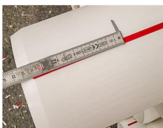
6. Marquage de la profondeur d'emboîtement des deux extrémités de tubes
