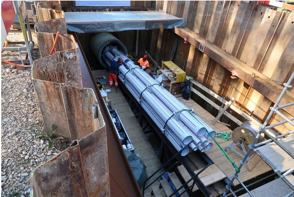
Figure 48: Insertion des tubes à fluides dans le microtunnel
