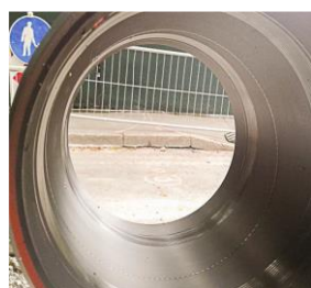
7. Vérification de l'état du manchon
