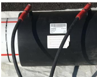
10. Lancement et surveillance du processus de soudage
