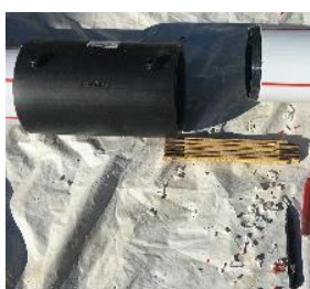
9. Emboîtement du tube dans le manchon
