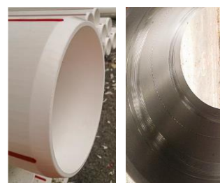
8. Nettoyage de la surface du tube et de la zone de soudure du manchon à l'aide d'un nettoyant pour PE
