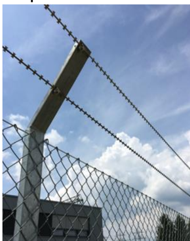
Clôture avec protection contre l'escalade
