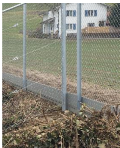
Clôture avec protection sous-terrain
