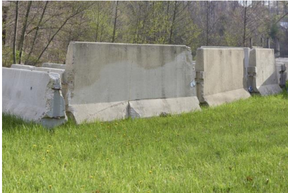
Abbildung 6 Beispiel von Betonschutzelementen
