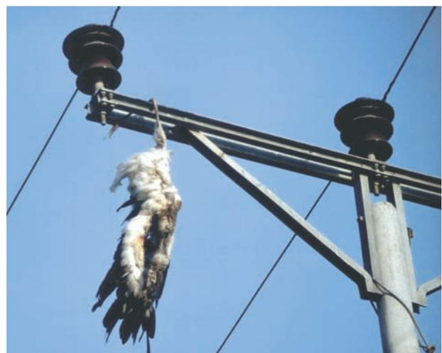
*Fig. 2: Una cicogna bianca morta in seguito a folgorazione su un traliccio con isolatori rigidi. Un'altra cicogna giaceva morta per terra. (foto: G. Fiedler)*
