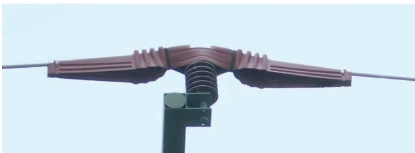
*Fig. 7: Isolatori rigidi con involucri di protezione. Il materiale isolante di rivestimento deve ricoprire i conduttori da entrambi i lati degli isolatori su una lunghezza di almeno 60 cm. (foto: A. Aebischer)*
