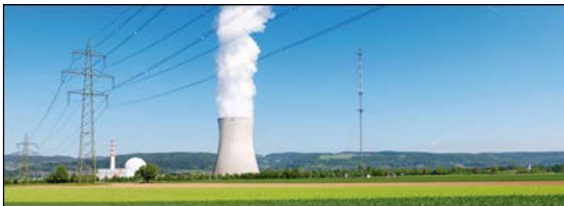
Illustration 4. Refroidissement dans une tour de réfrigération: centrale nucléaire de Leibstadt. Source: Swissnuclear ( www.energienucleaire.ch )
