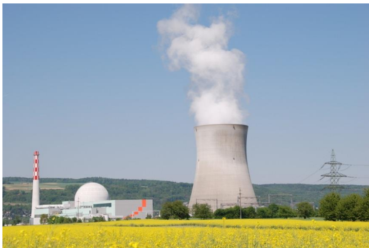
Illustration 4: Refroidissement dans une tour de réfrigération, centrale nucléaire de Leibstadt (source: Axp0 ).
