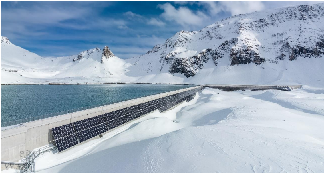
Abbildung 5 Blick auf die alpine Solaranlage auf der Muttseestaumauer im Winter 2023 (Axpo Holding AG, 2024)
