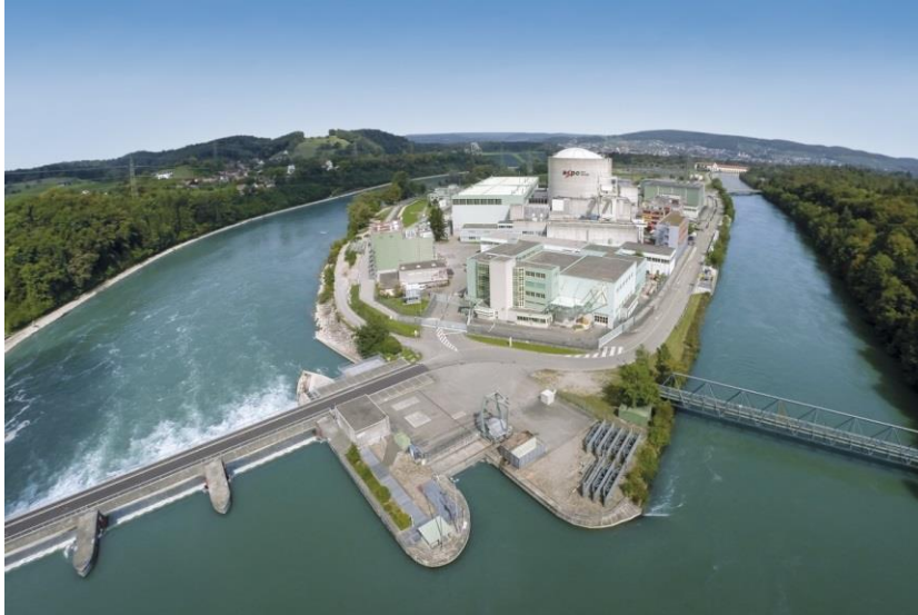
Abbildung 3: Kühlung mit Flusswasser im Kernkraftwerk Beznau (Quelle: Axpo).
