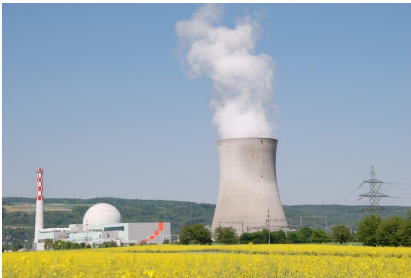
Abbildung 4: Kühlung mit Kühlturm im Kernkraftwerk Leibstadt (Quelle: Axpo).
