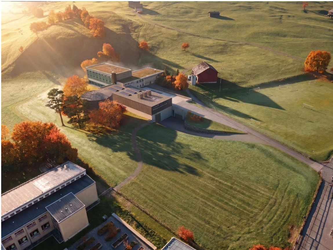
Abbildung: Im Gründli Glarus entsteht eine Energiezentrale für die Wärmeversorgung von über 400 Liegenschaften
