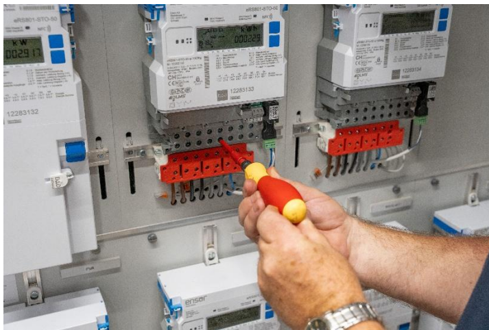
Zählermonteur installiert Smart Meter Zähler / Foto: EWO
