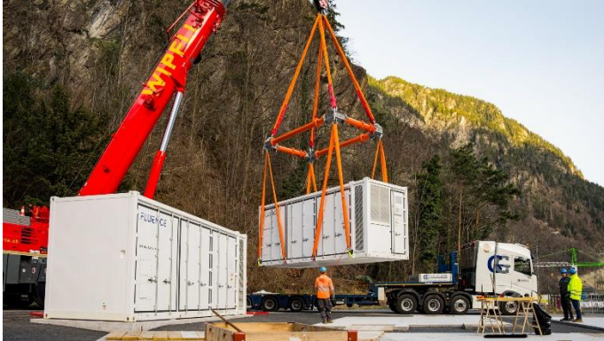
Aktuell läuft im Plattischachen die Anlieferung der Grossbatteriespeicher.
