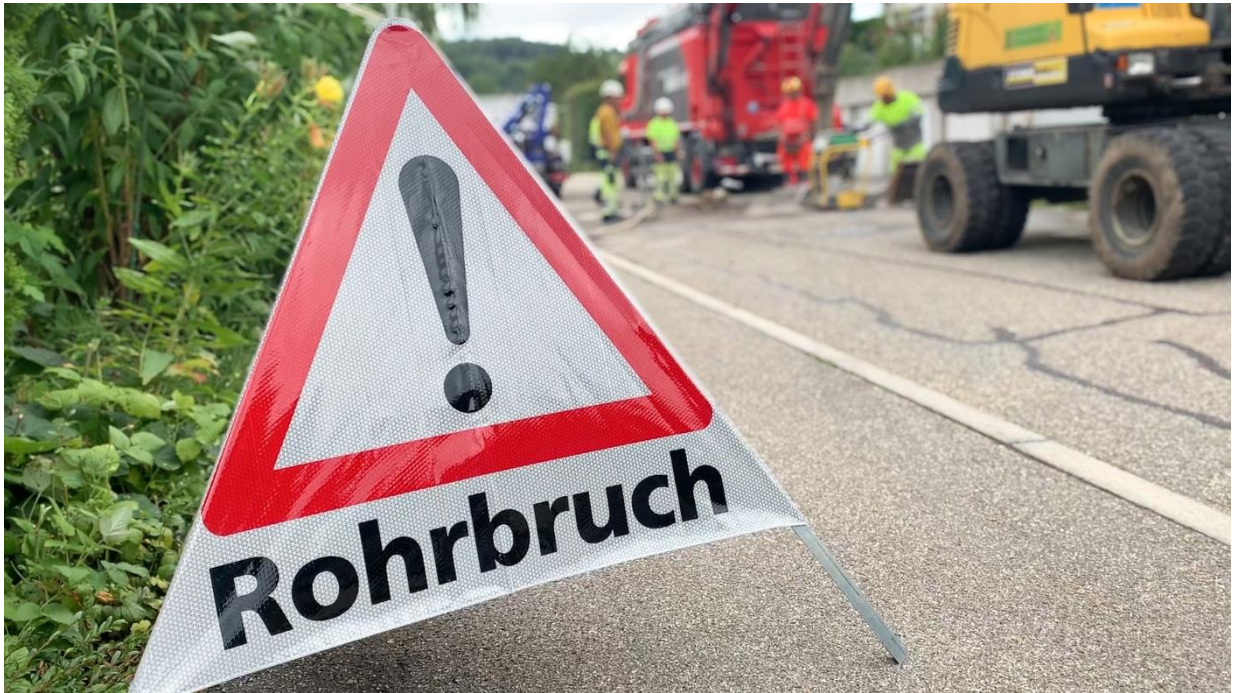
Bildlegende: Der 24h-Pikettdienst von StWZ hilft, zum Beispiel bei einem Wasserleitungsbruch, nachts, an Wochenenden oder an Feiertagen.
